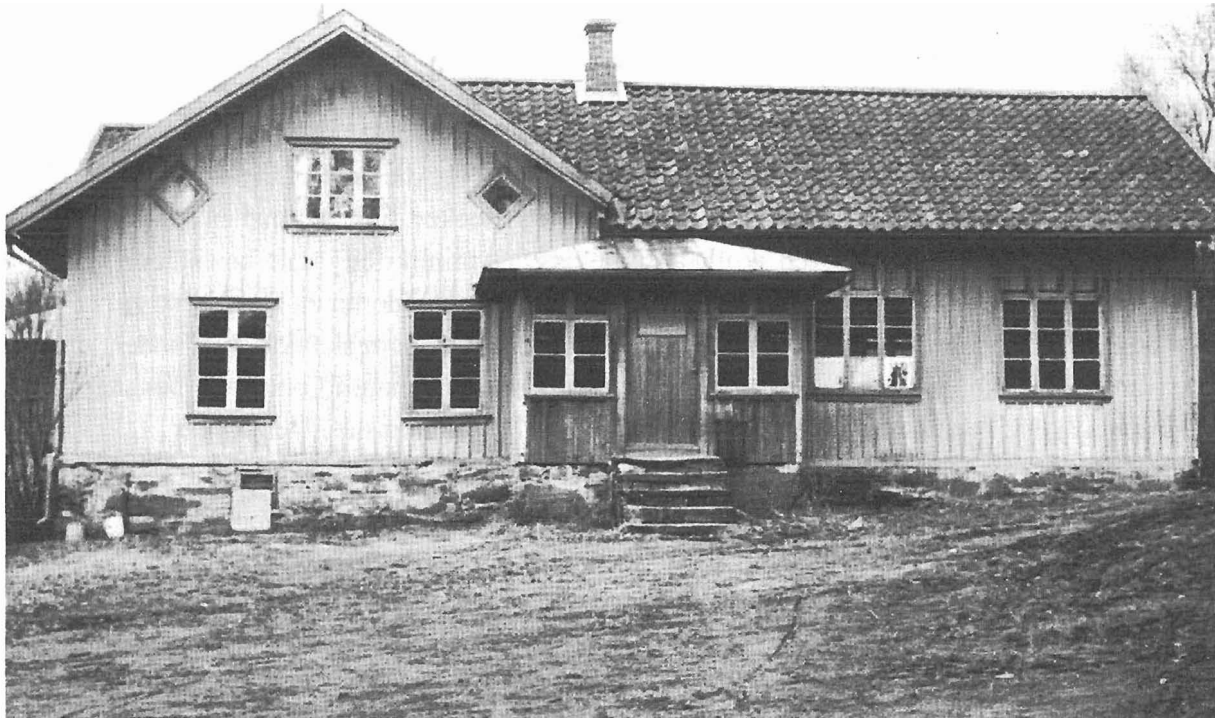
Karstorps Folkhögskola, numera ombyggd till småskola. Flygeln åt höger är rivet. Skolan donerades av prosten Paulsson 1855. Flygeln är en senare tillbyggnad. Den gamla skolsalen, gavelfönstren till vänster, var i många år kommunalrum för Öxnevalla kommun. Foto: K. Hansson.
