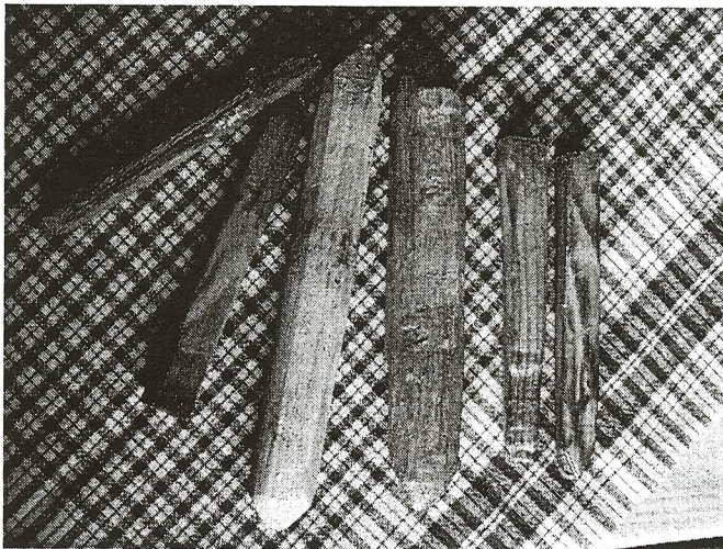
Bild 2. Ett foto av några dymlingar från Bjära, en slags träpluggar som användes i byggnader förr, troligen gjorda av furu och ek. De mindre kan ha suttit i en vägg där kravet på isolering inte var lika högt, en uthusvägg med andra ord.
